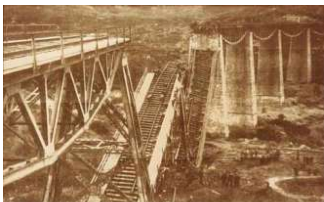
Η ανατίναξη της Γέφυρας του Γοργοπόταμου
