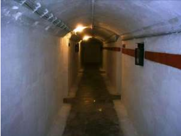
Το εσωτερικό του οχυρού
